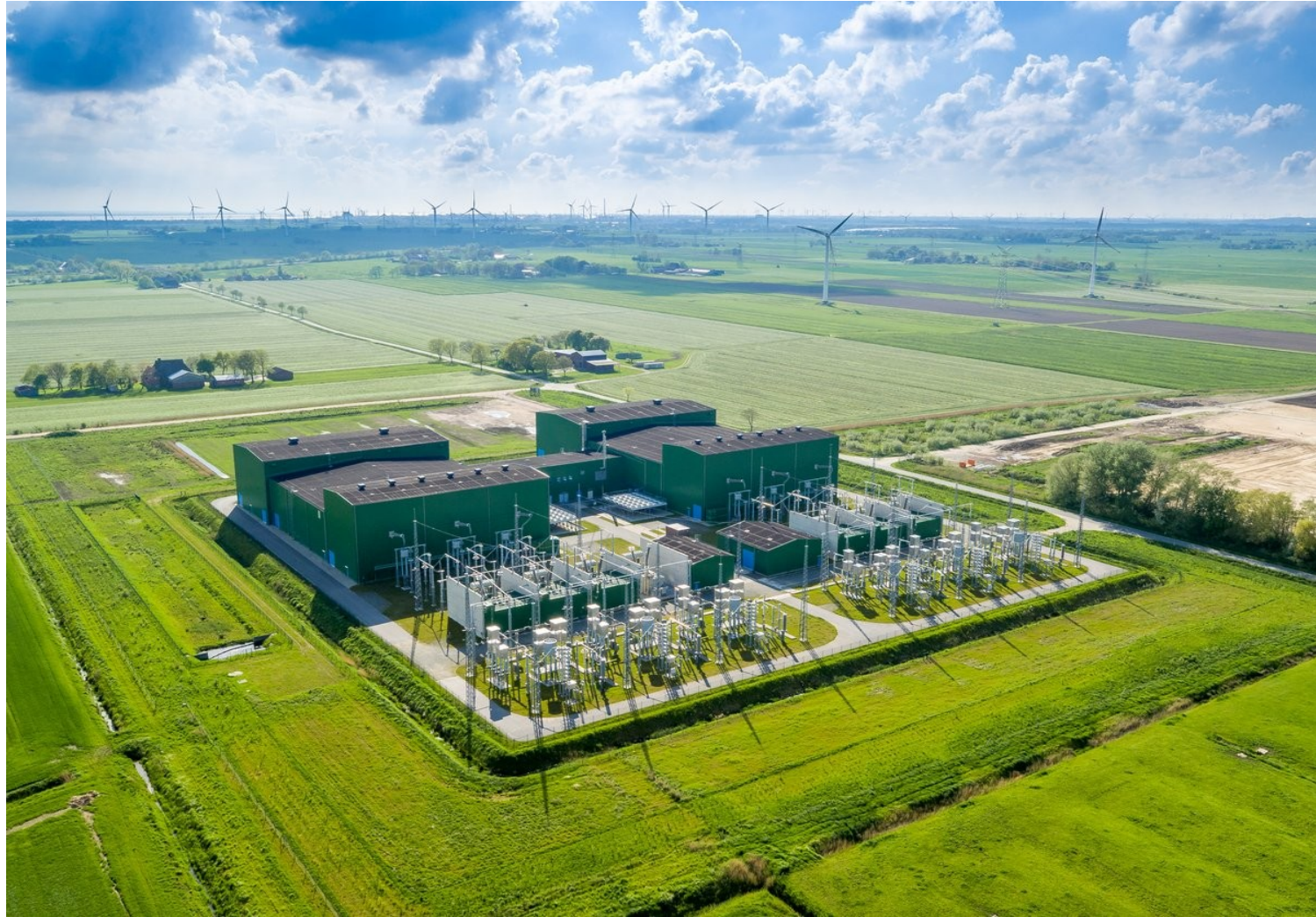
Estación Convertidora 1,400 MW, 525 KV DC/AC AC/DC
